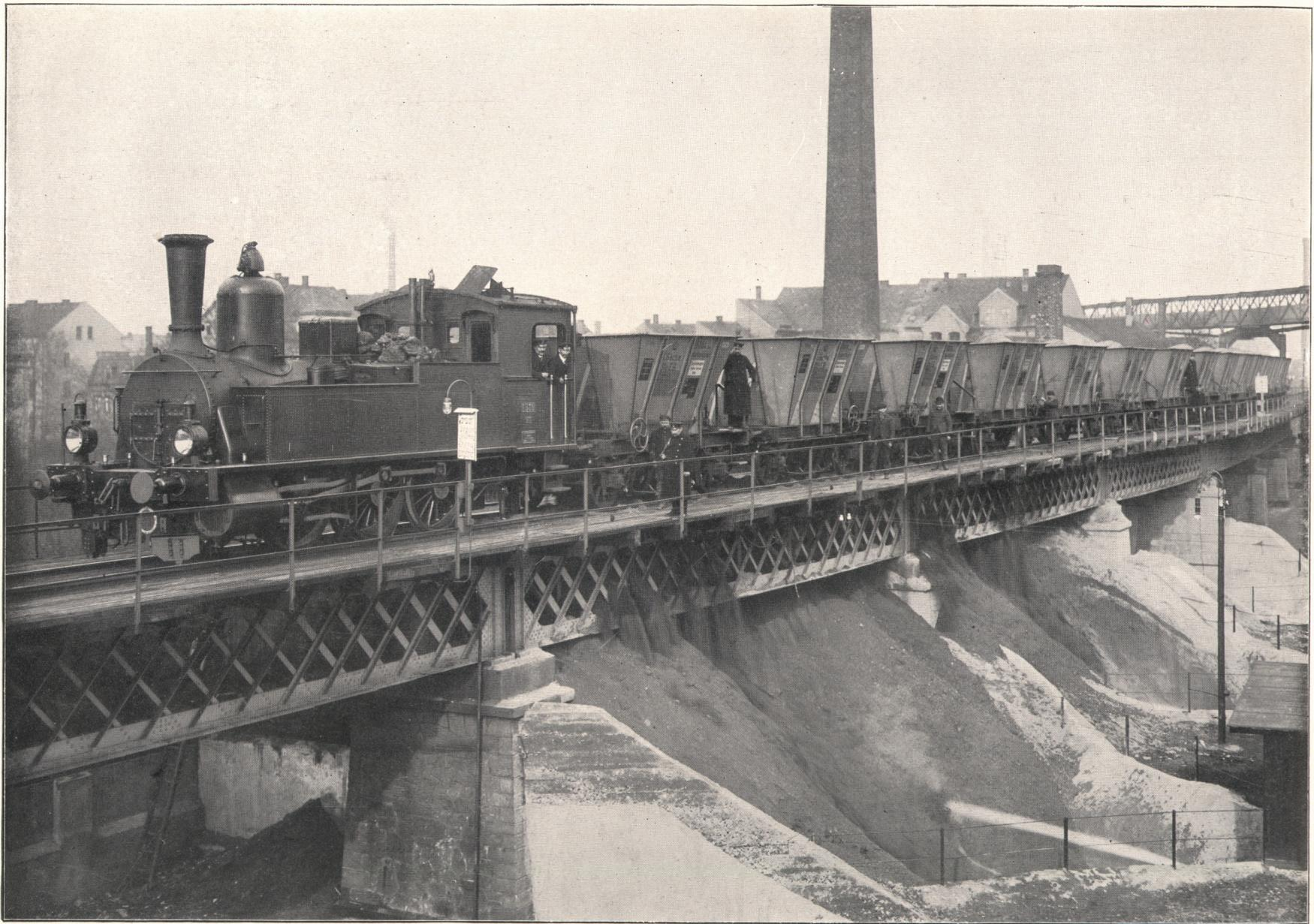
Ansicht der Entladung der auf S. 36/37 abgebildeten und beschriebenen Bodentleerer, Bauart C, für Sandtransport.
